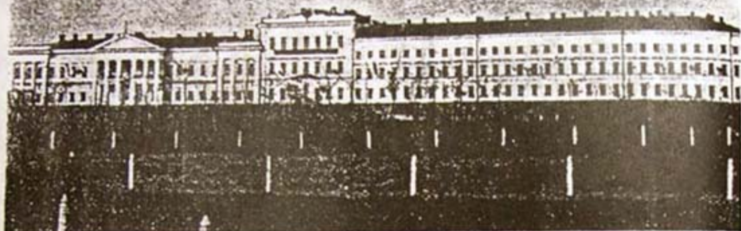
Передній фасадъ здания, подвергнувшійся обстрѣлу красноармейцевъ 6-го февраля 1918 г
